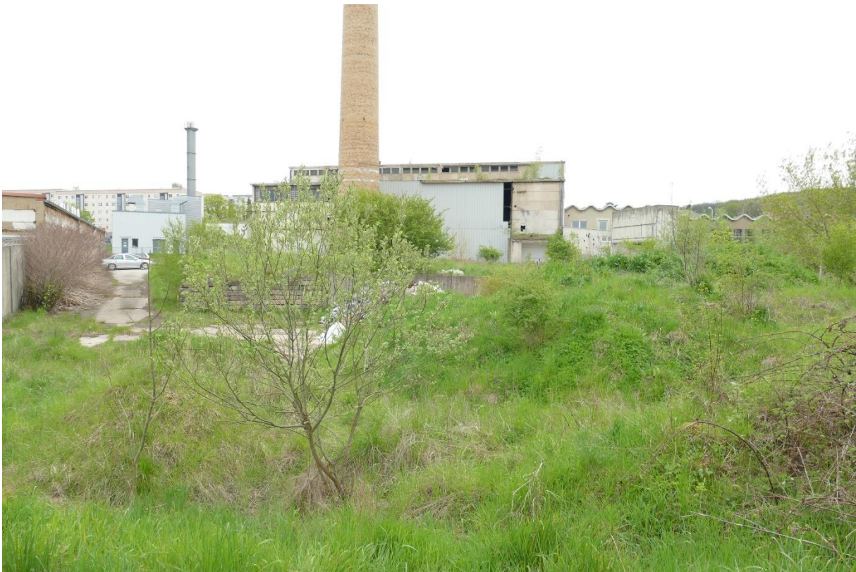
UG Eisenberg (Blickrichtung von Ost nach West), ehem. Heizkraftwerk im Mittelpunkt, 05.05.2023, Foto C. Schuster
